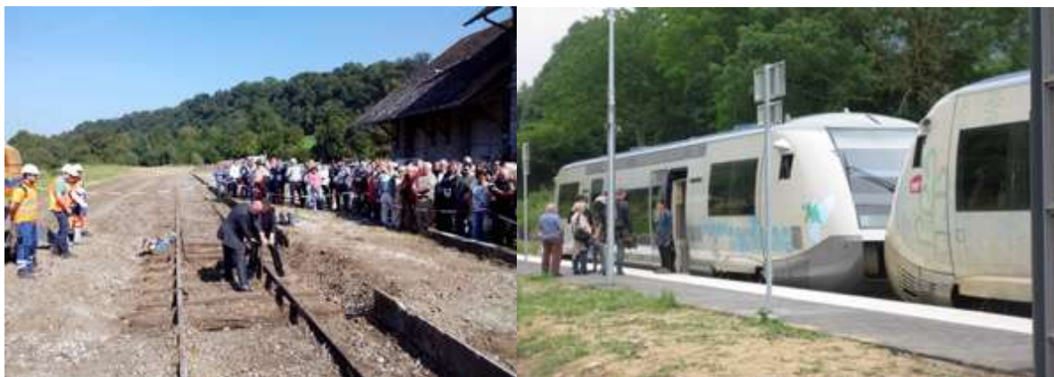
Lancement des travaux de reconstruction, puis autorail régulier en gare de Bedous (DR).
