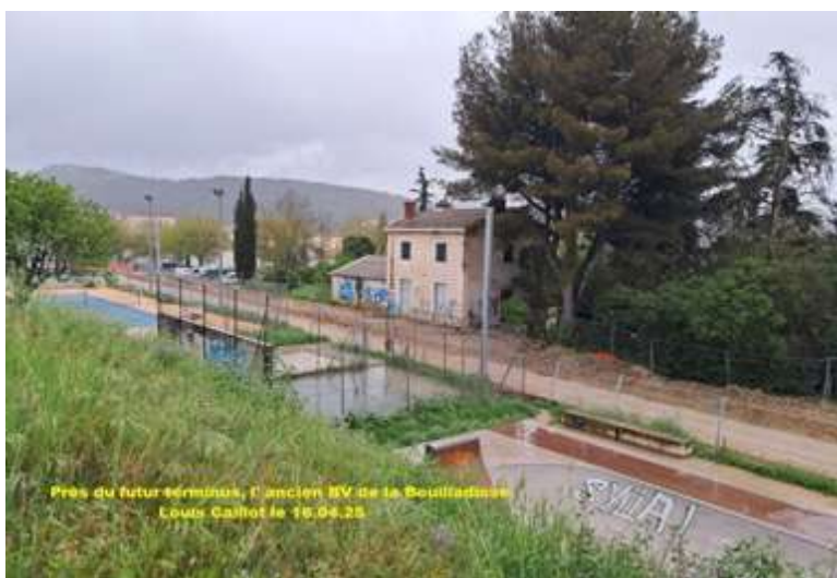
Reconstruction en cours de la ligne Aubagne - La Bouilladisse. Photo Louis Caillot, association Rail et industrie.
