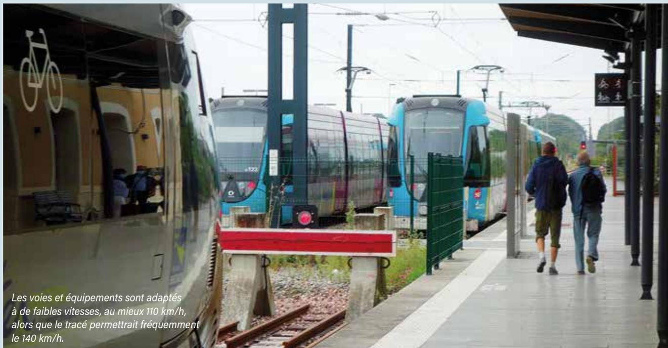
Les voies et équipements sont adaptés à de faibles vitesses, au mieux 110 km/h, alors que le tracé permettrait fréquemment le 140 km/h.
