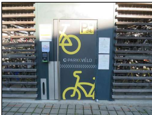
Parc à vélos de la gare de Pontchaillou (36 places)
