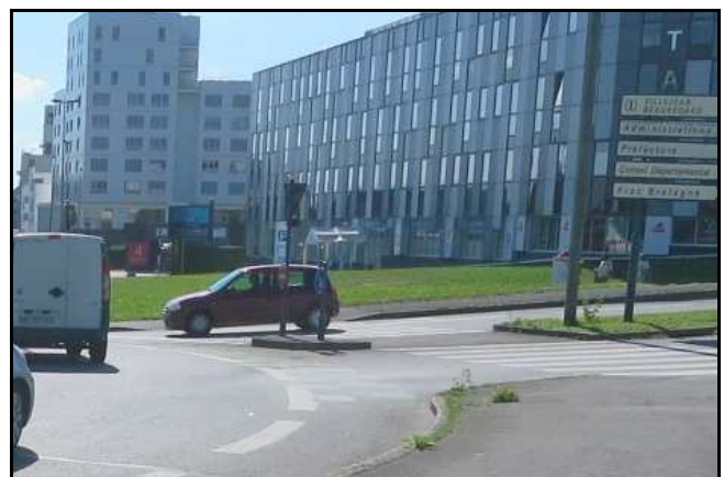
Entrée et sortie de giratoire sans îlot pour protéger les cyclistes (N137, route de Saint-Malo)
