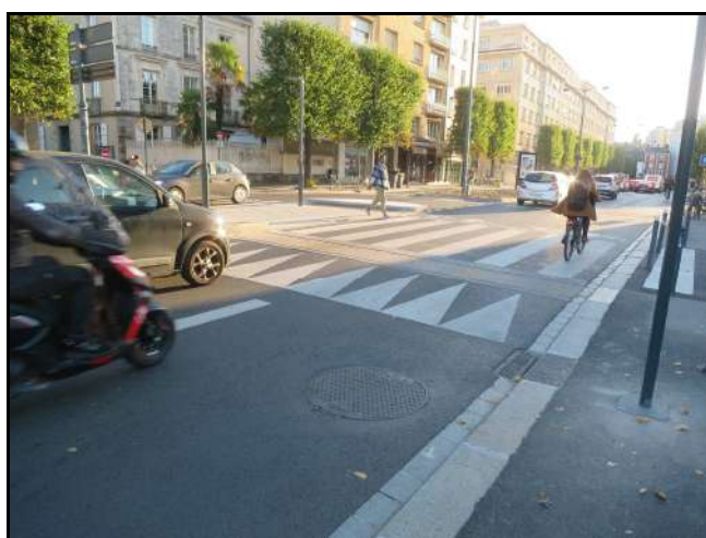
Traversée à niveau avec plateau surélevé (Rennes)
