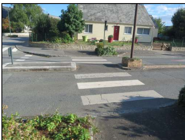
Abaissé de trottoir et îlot central (Chantepie)
