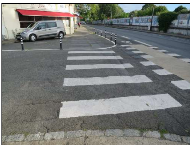
Réduction du rayon de giration et raccourcissement de la traversée avec des potelets (Tours)
