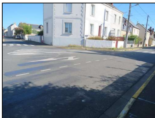
Traversée obligeant les piétons à faire un détour (Saint-Pierre-des-Corps)
